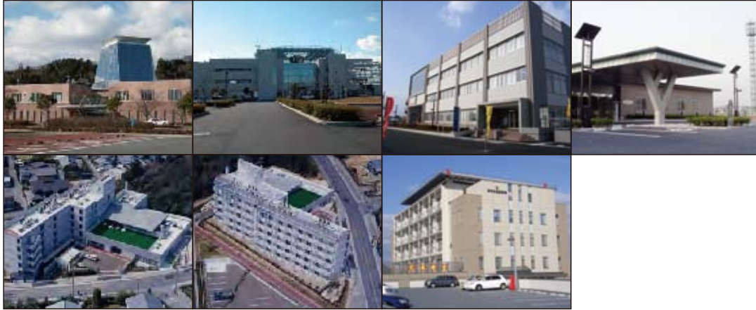
一般施設照明 一般建築物の 照明設備
