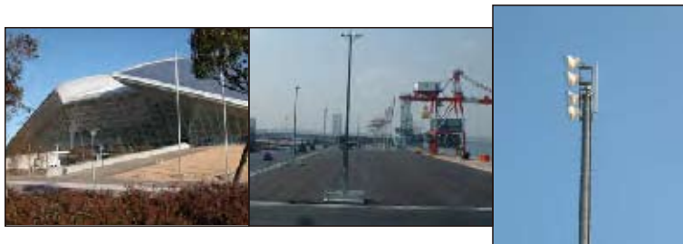
屋外施設照明 公園、歩道等の 照明設備
