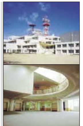
学校施設照明 学校関係の 照明設備
