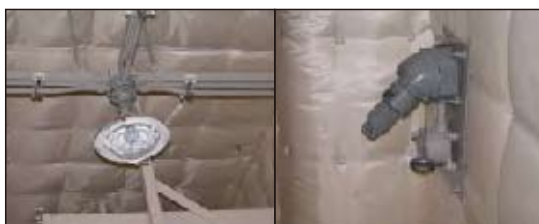
防爆施設照明 石油プラント等の 特殊安全構造の照明
